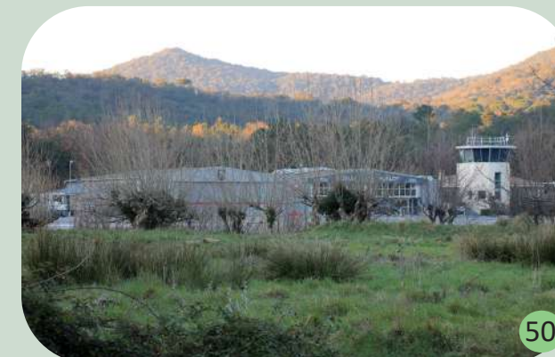
50 - Aéroport de la Môle
