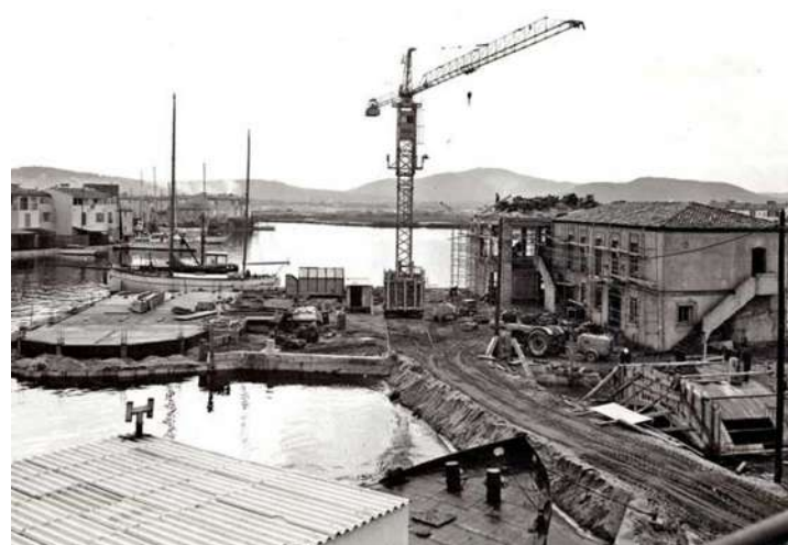
Port-Grimaud pendant les travaux
