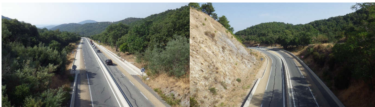
Vue de la RD25 depuis sont franchissement au niveau du Col de Gratteloup
