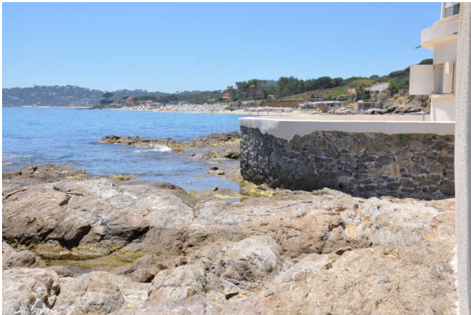
Mur soutènement Terrasse
