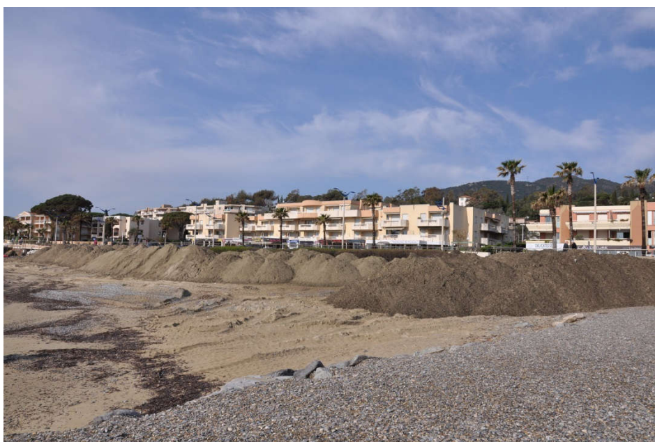
Stockage des sédiments avant étalement sur la plage – Cavalaire 2017
