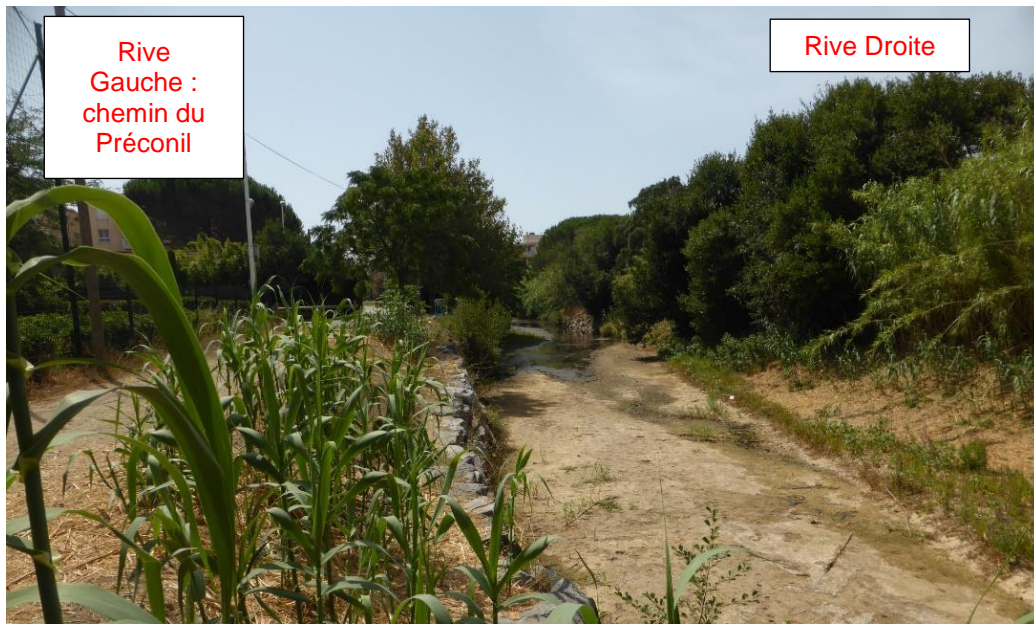
Figure 10 : Photo du Préconil. Source : INGEROP – 03/08/2017.
