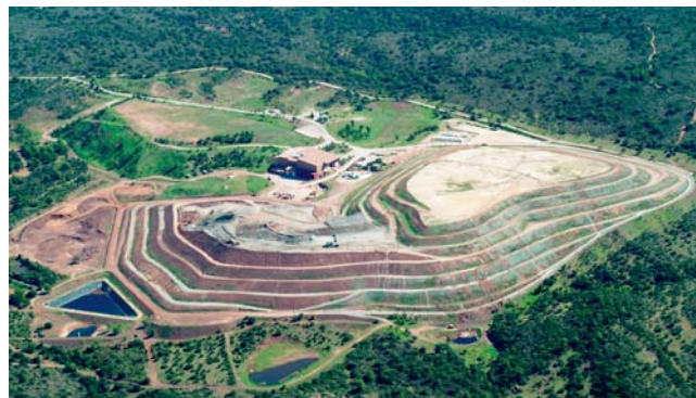
ISDND du Balançon
