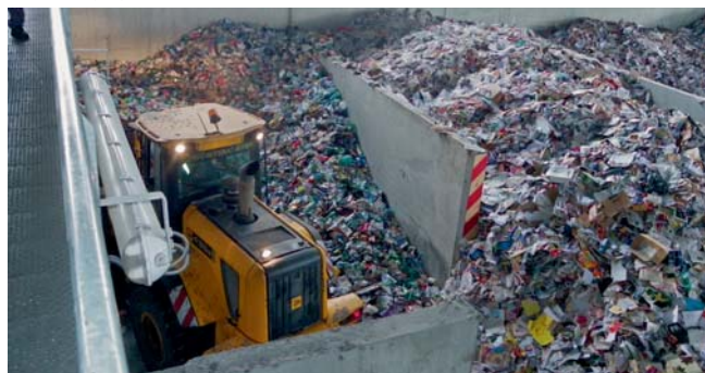
Entrée centre de tri : alvéoles de réception
