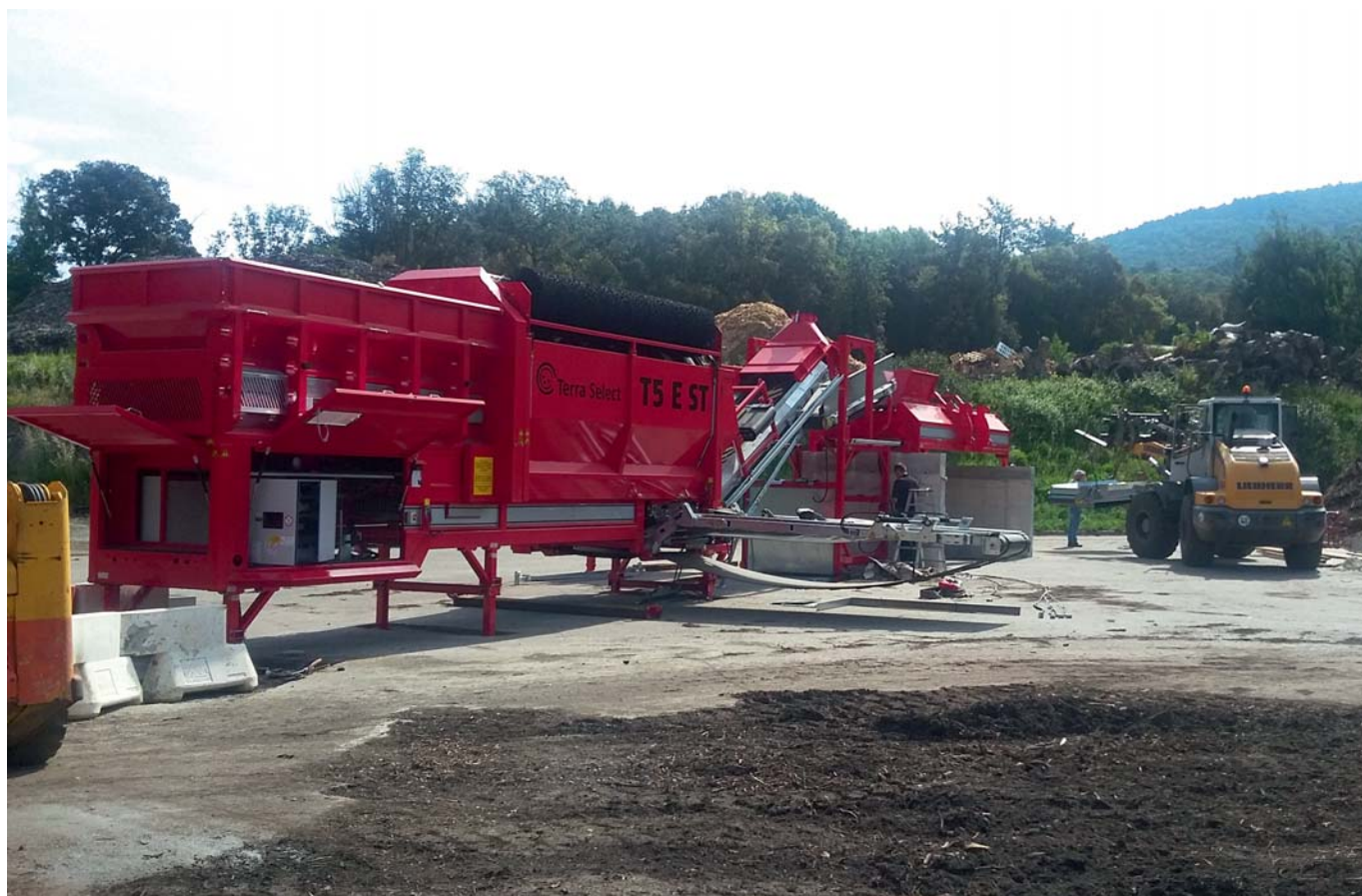
La ligne d'affinage lors de son installation
