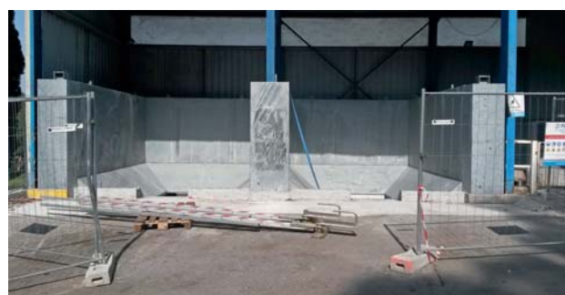
Trémies pour le vidage dans des FMA (en cours d'installation)
