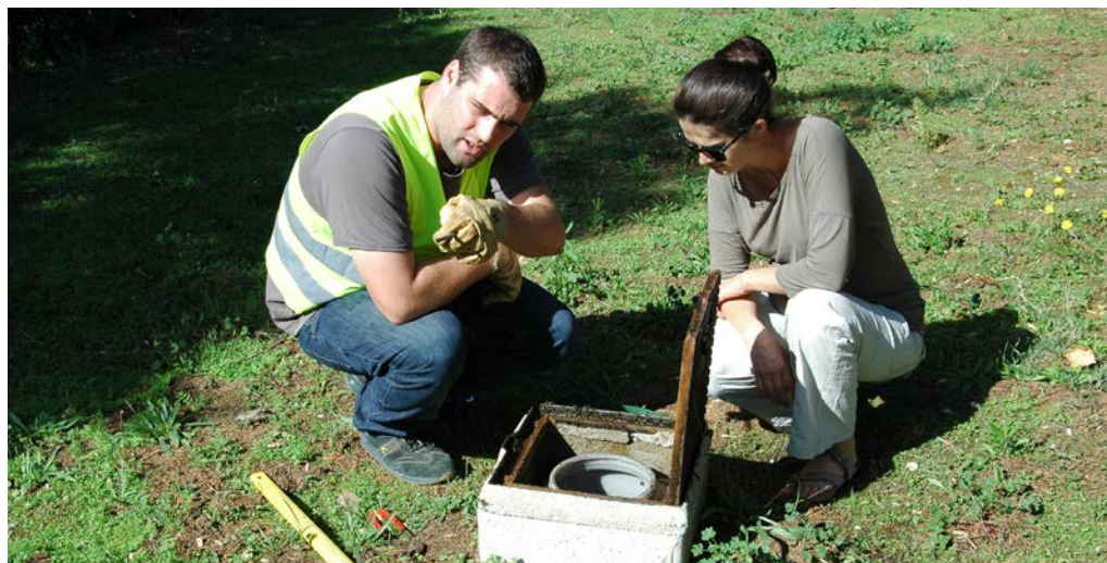
Un agent est affecté au SPANC et procède, sur le territoire où le service n'est pas délégué, au contrôle des installations d'assainissement autonomes
