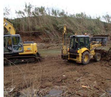
Travaux d'urgence d'enlèvement d'embâcles
