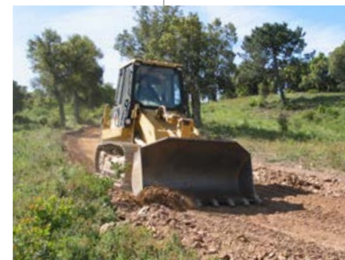
Travaux sur les pistes
