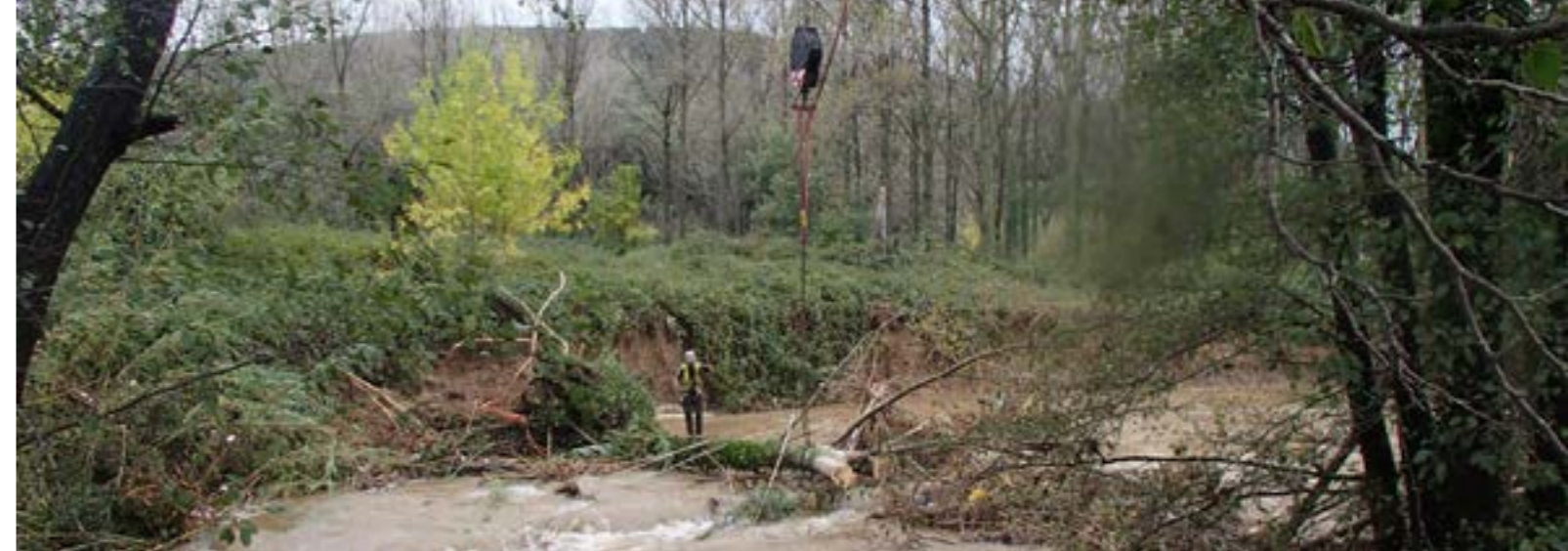
Travaux d'urgence sur les cours d'eau suite aux inondations de novembre 2014
