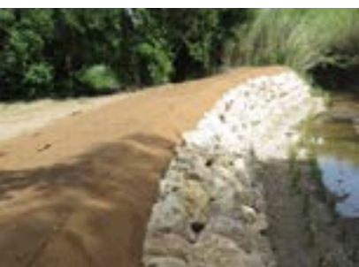
Travaux post crue du 14 décembre 2012
