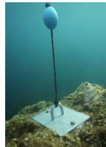
Scellement sur roche pour l'aménagement des sites de plongée
