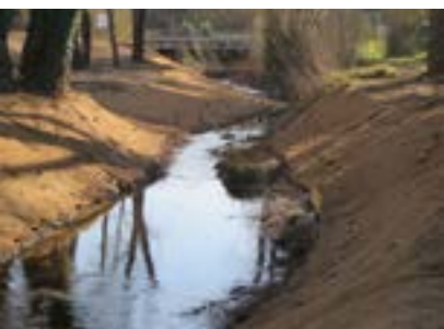
Terrassement des berges du Béliu selon une pente adaptée et stabilisation des talus
