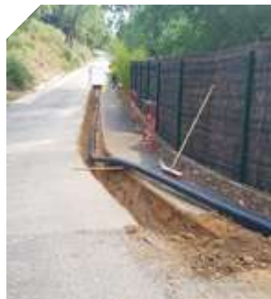
Renforcement du réseau d'eau potable à Guerrevielle
