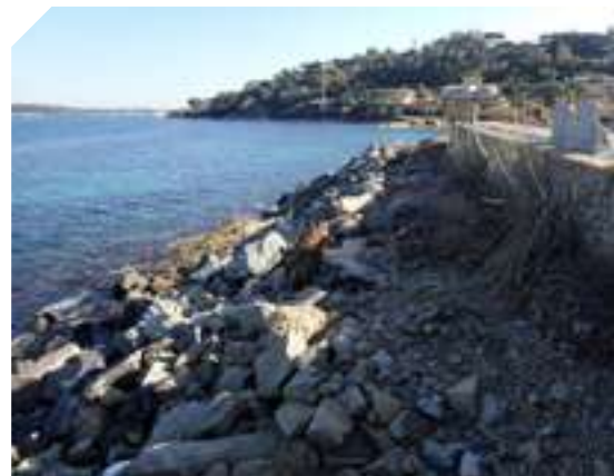
Enrochement protégeant le cimetière de Saint-Tropez
