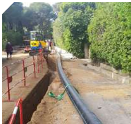
Renforcement du réseau d'eau potable dans le Parc des Salins
