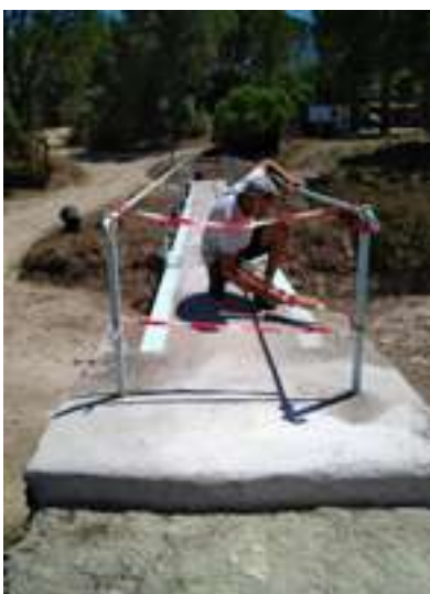
La Passerelle des Gorgues en cours de restauration
