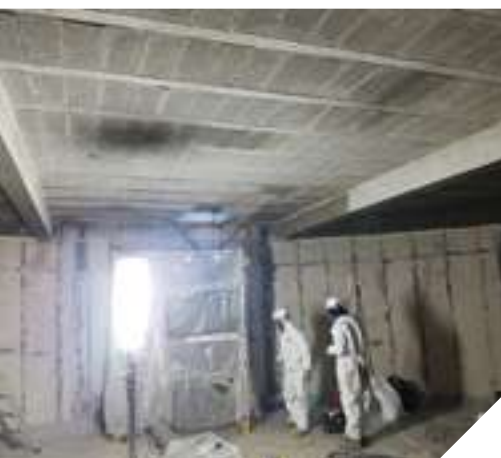
Réhabilitation du réservoir de Gigaro
