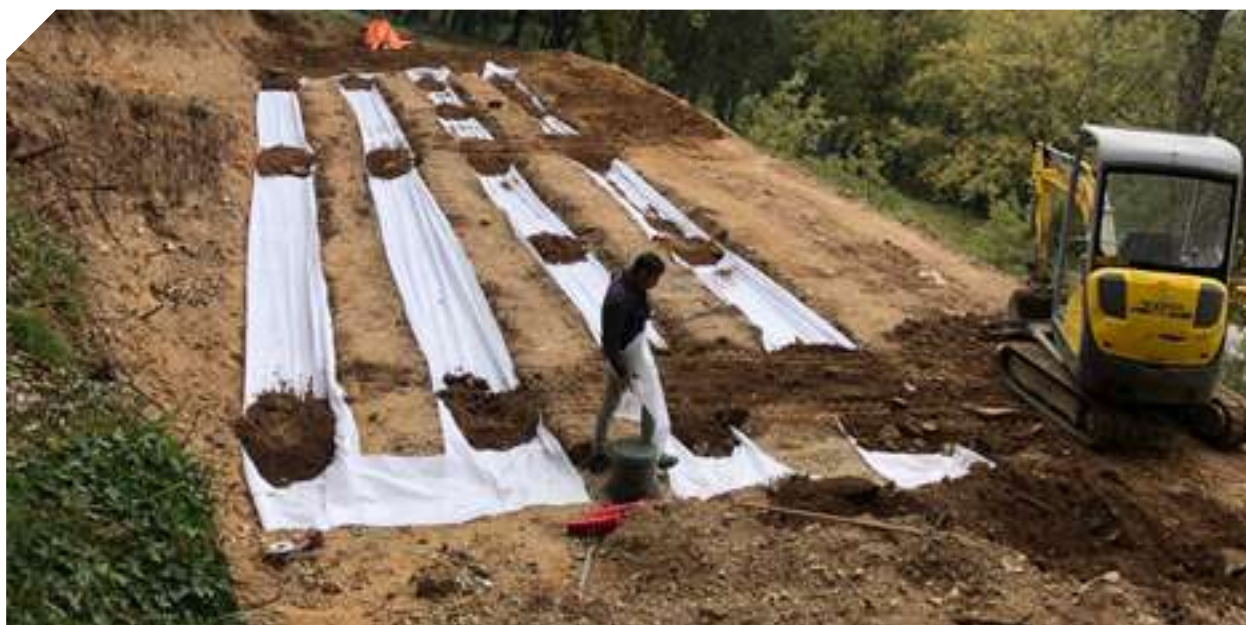
Contrôle d'installations d'assainissement non collectif
