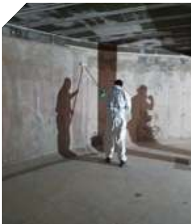
Réhabilitation du réservoir de Thalassa
