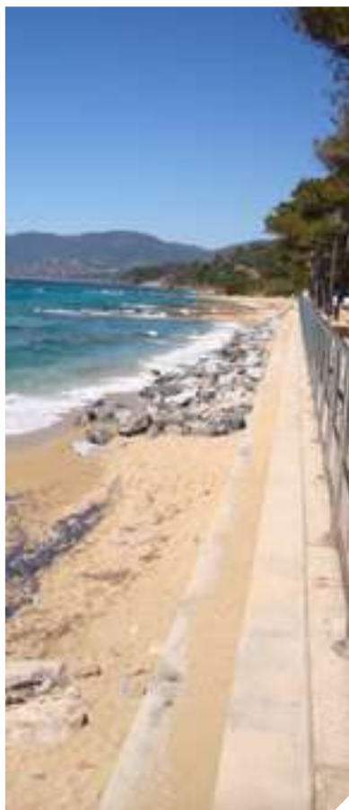
Mur de soutènement du boulevard de la Mer à Gigaro
