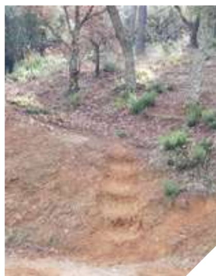
Réalisation de marches sur un talus pour faciliter le parcours
