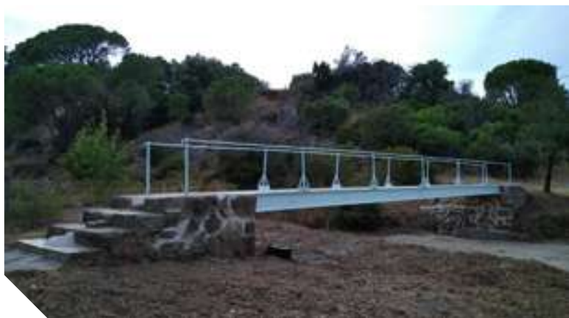
La Passerelle des Gorgues après restauration
