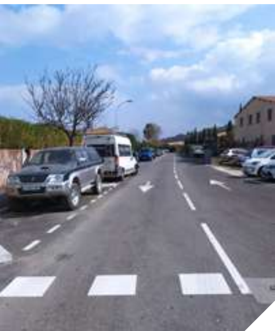
Travaux réalisés en phase 2 dans le Parc d'Activités Saint-Maur
