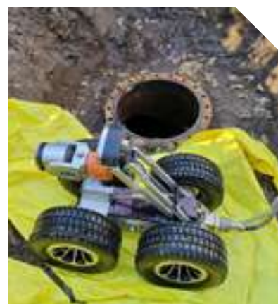
Inspection par caméra en décembre 2020
