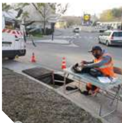
Travaux de déploiement de la fibre à Cogolin
