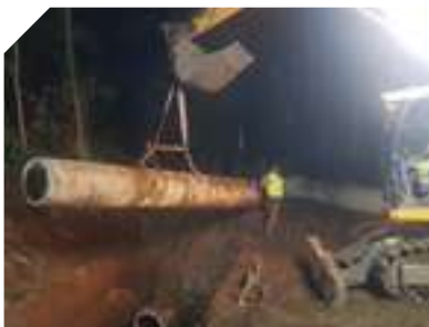
Remplacement d'un tronçon de canalisation dans la nuit du 3 au 4 août
