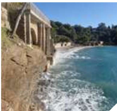
Escalier du Bailly de Suffren
