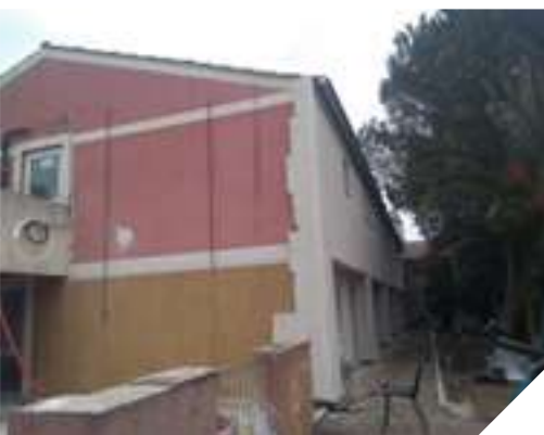
Isolation extérieure de l'ancien bâtiment
