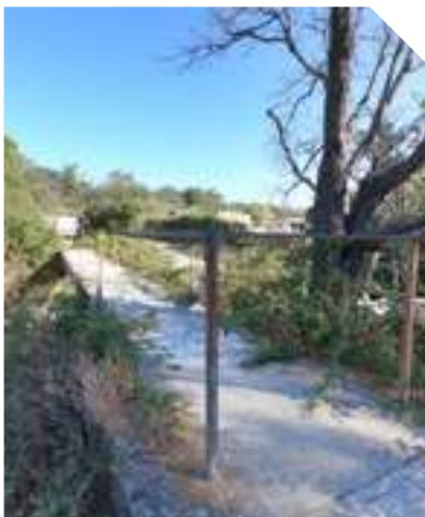
La Passerelle des Gorgues avant restauration
