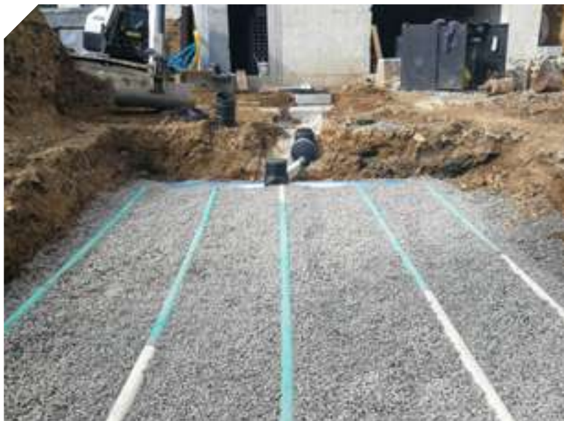
Contrôle d'installations d'assainissement non collectif
