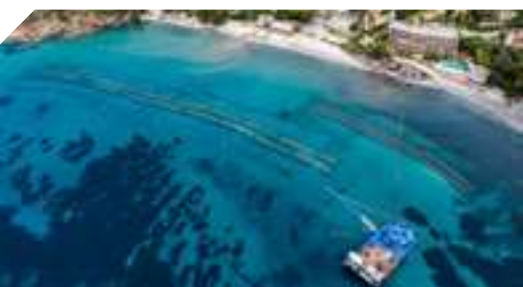
Vue aérienne des travaux réalisés en 2020 au droit de la plage du Rayol
