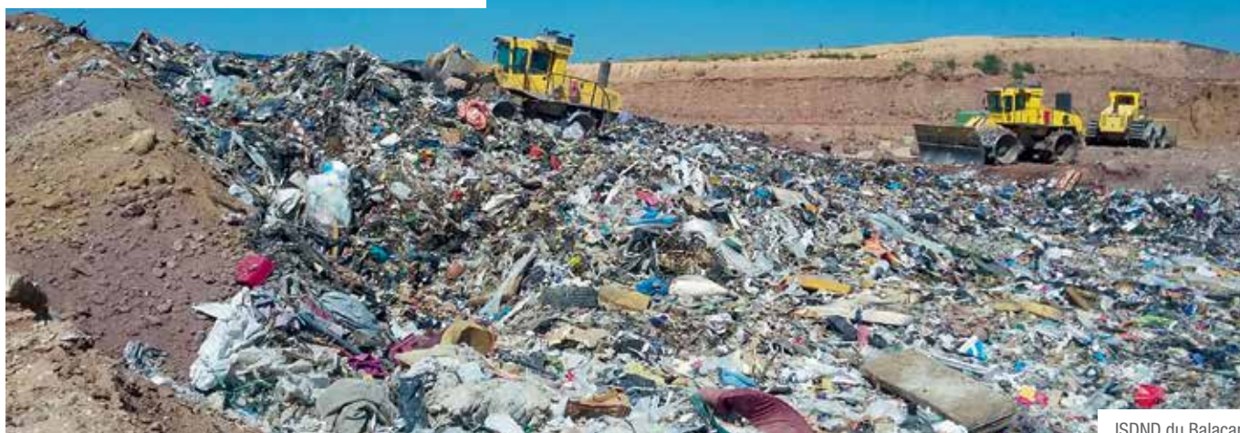
ISDND du Balançon
