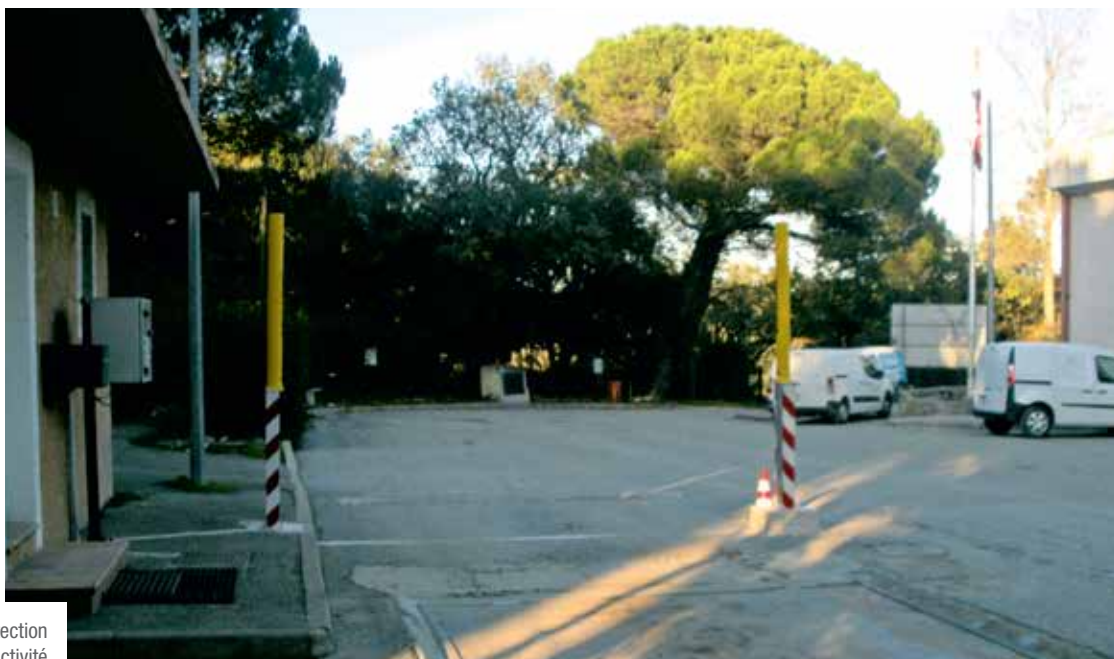
Pont hors sol de 18 m pour pesées des semi-remorques FMA
