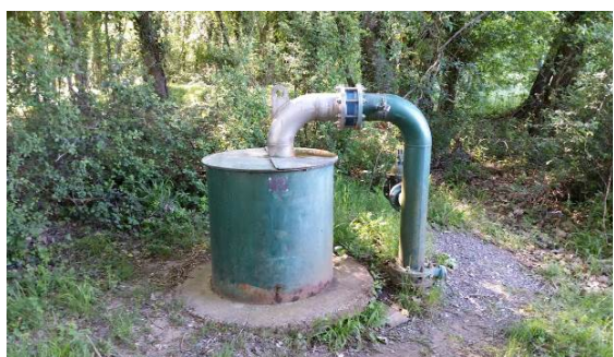
Forage du Rayol
