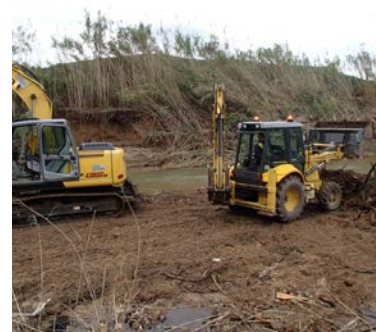
Travaux d'urgence d'enlèvement d'embâcles
