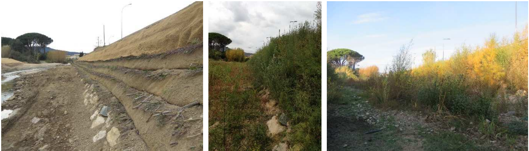
Préconil – en aval du site de Brisach - Aménagement de berge en génie mixte (photos prises respectivement en mars 2016, octobre 2016 et novembre 2017)
