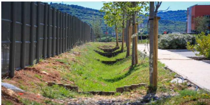
Infiltration à la source au parc d'activité des Bréguières (Arcs-sur-Argens 83)
