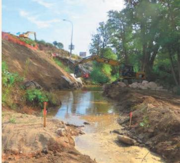
L'AM n° 13, dont l'objectif est de protéger la zone située à l'est de l'affluent nommé l'Avelan, prévoit le débroussaillage de la zone de travaux et la construction d'un système d'endiguement dans l'extrémité Est du lit majeur.
