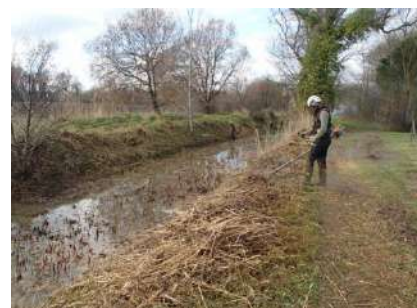
Figure 54 Entretien d'un fossé de ressuyage (Saint-Pierre)
