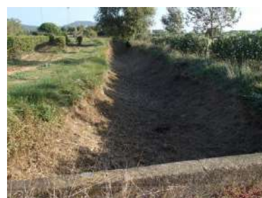
Figure 55 Fossé de ressuyage de la Gisclette après entretien
