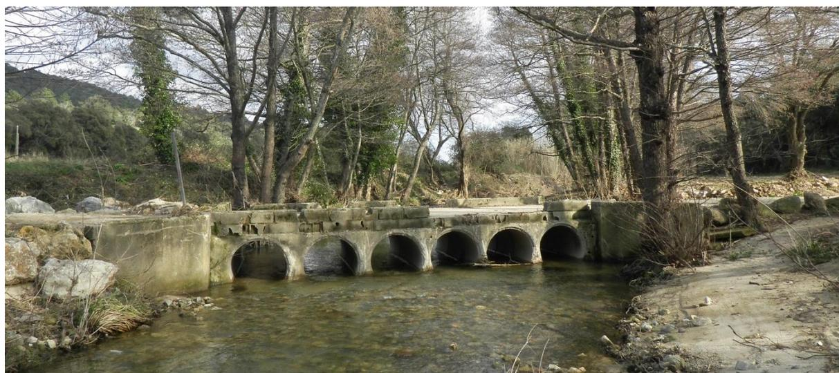
Ce second ouvrage se situe à 130 m environ en aval du précédent. La dynamique y est similaire avec un exhaussement du fond de lit du même ordre de grandeur (50 cm). La dynamique sur cette zone reste inverse à celle observée sur la comparaison des profils en long en aval, au niveau de Camp Ferrat.
