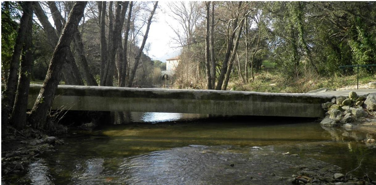
Un exhaussement du fond de lit est visible sur cette photographie. Ce dernier est de l'ordre de 50 cm. La dynamique sur cette zone semble donc inverse à celle observée par la comparaison des profils en long en aval, au niveau de Camp Ferrat.
