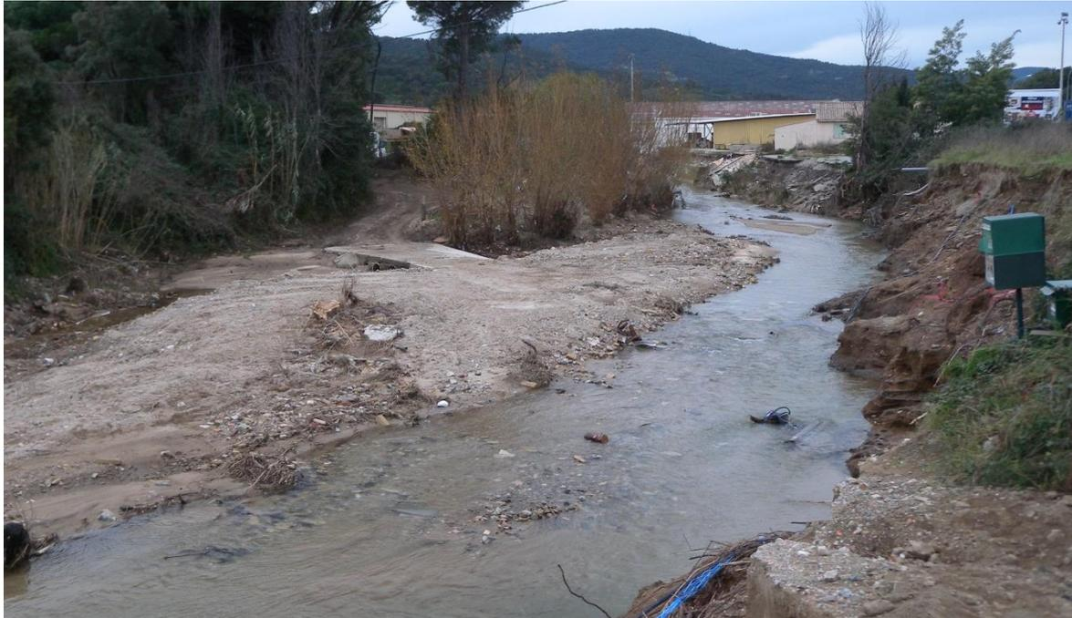
La comparaison des deux clichés laisse apparaître une situation similaire en terme de profil en long puisqu'on observe une ouverture similaire sur la buse en rive droite et un fond de lit quasi équivalent entre la buse rive droite et la zone d'écoulement principal en rive gauche. Cette situation est similaire à celle observée sur les profil en long.
