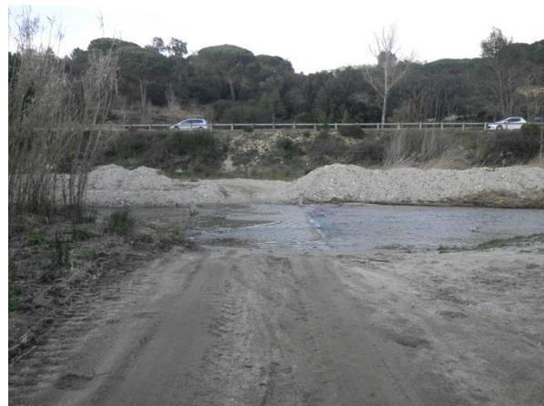
Ce troisième ouvrage se situe à 450 m environ du précédent, dans une secteur au lit mineur élargi avec des berges basses et avec une rupture de pente. La dynamique reste similaire mais avec un exhaussement du fond qui semble accru, de l'ordre de 0.8 à 1.0 m. La dynamique globale jusqu'à ce site reste donc inverse à celle observée sur la comparaison des profils en long en aval, au niveau de Camp Ferrat qui se situe 1700 m en aval.
